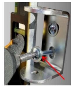
Installer la platine et ajuster la visée
