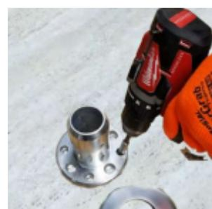
Percez les trous avant de fixer la platine. Celle-ci comporte trois trous prévus pour des vis de 7,5 x 80 mm.
