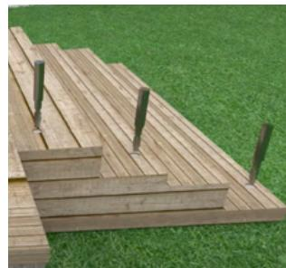
Insérez le pied d'ancrage dans le trou rempli de scellement
