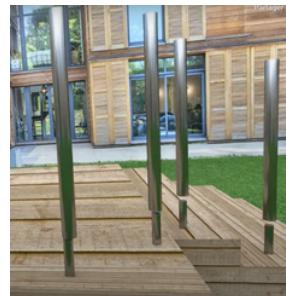
Appliquez le scellement chimique sur le pied d'ancrage, puis insérez le poteau.
