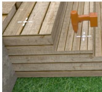
Percez un trou de 16mm puis injectez du scellement chimique
